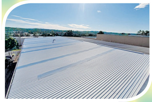
Lipa在倉庫屋頂採用熱能反射漆(SkyCool)有助保持倉庫清涼，及減少耗能。
